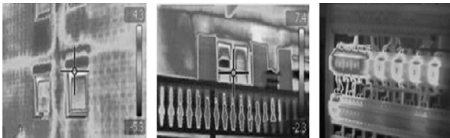
Ukázky měření: tepelný most, vznik plísní, zatékání, podlahové topení, fotovoltaické panely, elektroinstalace, zateplená budova
